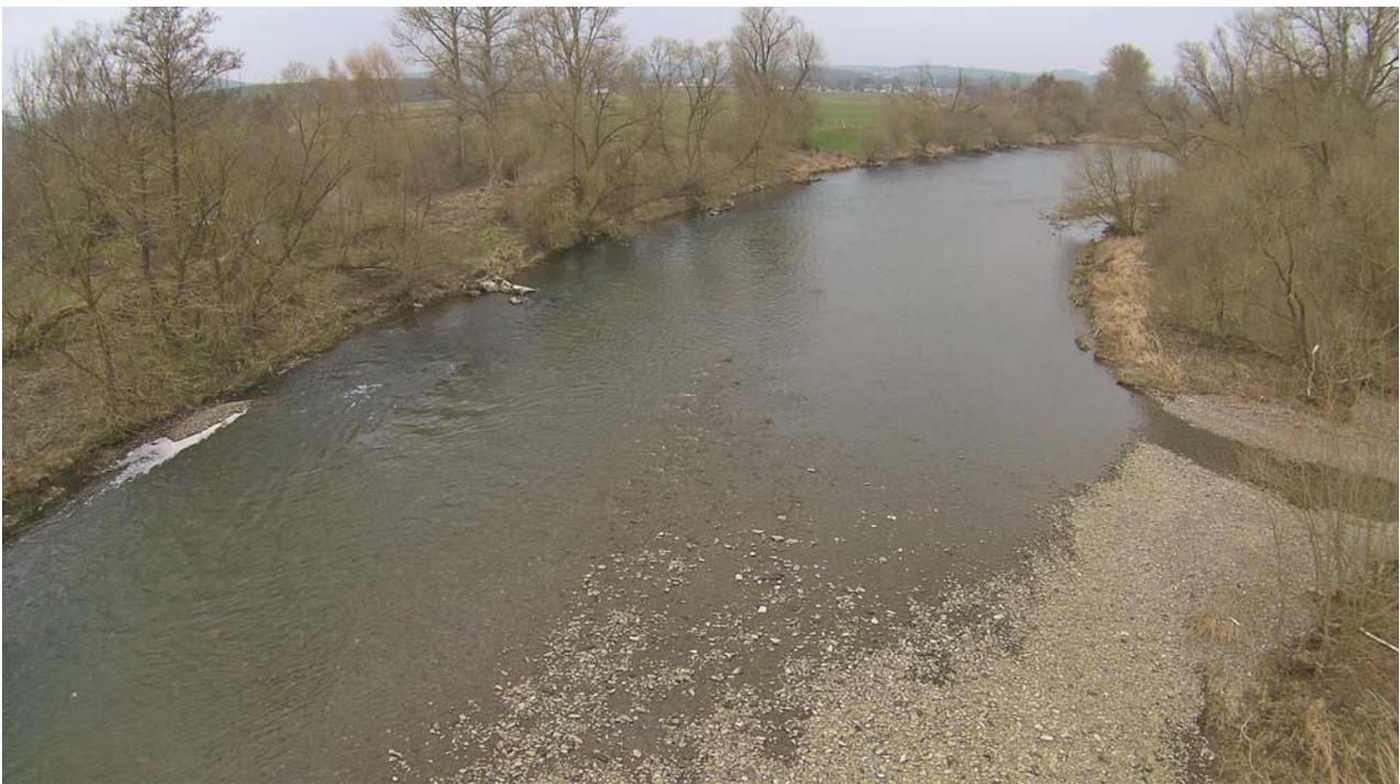
Abb. 7: In die Eder im Zuge der Renaturierungsmaßnahmen eingebautes Kies- und Schottermaterial
