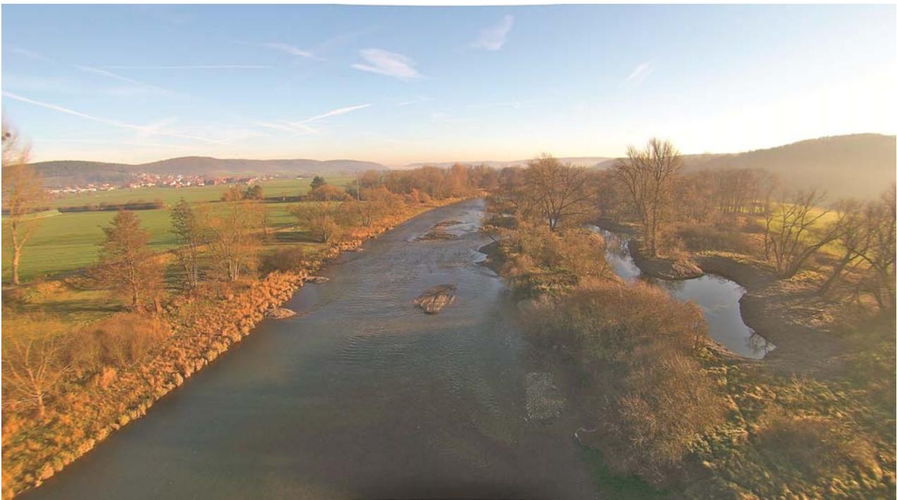
Abb. 6: Neu hergestellte altarmähnliche Struktur an der Eder in der Nähe von Anraff
